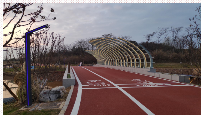
图为咸宁大洲湖生态建设示范区 PPP 项目环湖绿道工程
